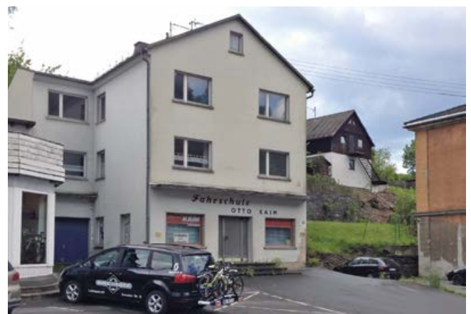
Wohn- und Geschäftshaus vorher
