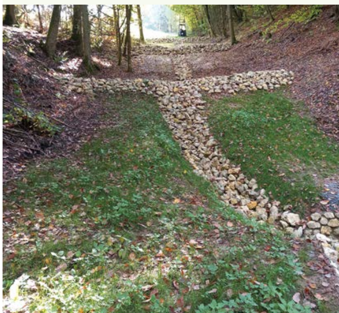
Kaskadenförmige Wälle zur Abflussverzögerung
